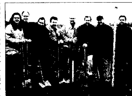
Am 28. März zum Bau des Tennisheimes: Mit dabei die gesamte Vorstandschaft mit Bauleiter Anton Brauchle und Architekt Ralph Traub (links) sowie Bürgermeister Ulrich Neumann (3. von rechts). Foto: privat
